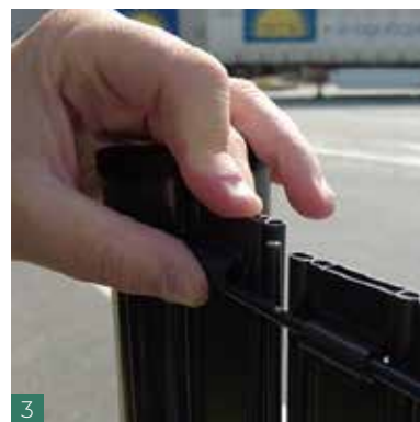
3 Positionner les lattes dans le panneau puis ajouter les clips plastiques sur la partie haute des lattes.
