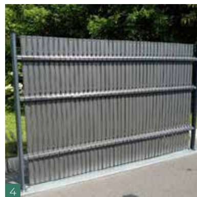
4 La latte se glisse à l'intérieur du panneau. Emboîtez les clips sur le fil horizontal supérieur. Glissez les lattes suivantes jusqu'au remplissage complet du panneau. (Prévoir un espace entre le panneau et la plaque de soubassement, afin de pouvoir poser plus facilement de l'occultation.)
